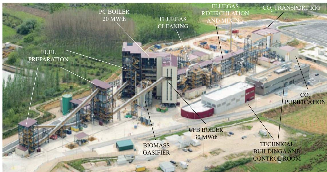
图 4 CIUDEN  $\text{CO}_2$  捕集与运输技术示意<sup>[37]</sup>
