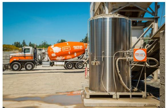
图 6 CO<sub>2</sub> 矿化预拌混凝土技术现场装置
