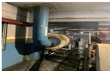
图 3 榆家梁选煤厂筛分系统安装洗气机
