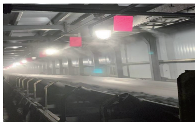
图 1 高压雾化喷雾系统降尘现场工作照片
