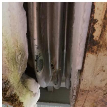
(b) 烟气再循环管道膨胀腐蚀
