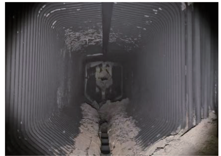
图6 孙家岔煤粉燃烧结焦情况
