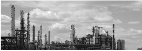
图6 神华煤制180万t/a甲醇转制60万t/a 烯烃商业化示范项目
