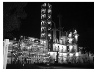
图2 产油1000 t/a的煤间接液化(合成气费托合成)中试装置
